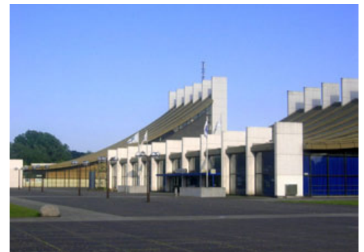
Testhalle in Castrop-Rauxel.
